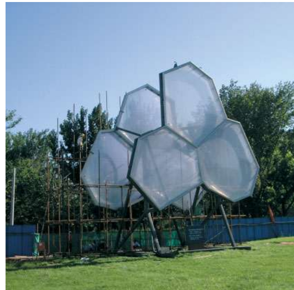
Gambar 4 Prototipe model fisik Watercube Aquatic Centre yang telah difabrikasi menggunakan ETFE sebagai material penutup bangunan. (Sumber: Weinstock, Self-organisation and material construction , 41)
