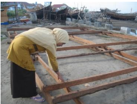
Gambar 3. Kerangka keramba setelah perakitan
