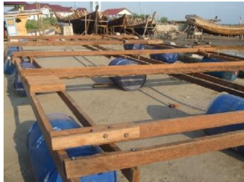
Gambar 4. Pemasangan drum pelampung
