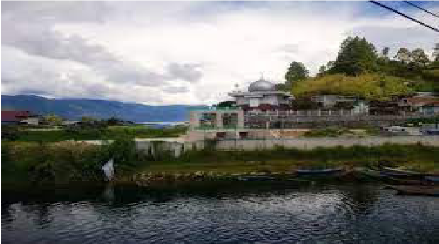
Gambar 2. Mesjid At-Taqwa Kampung Hakim Bale Bujang
