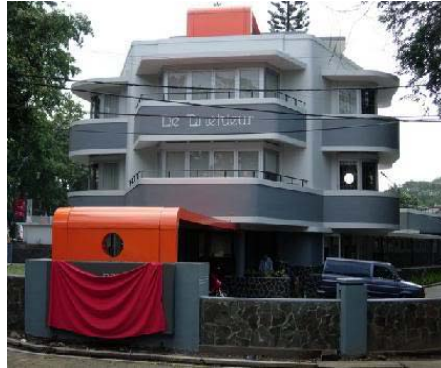
Figure 2. New Drie Kleur Building Source : http://djawatempodoeloe.multiply.com
