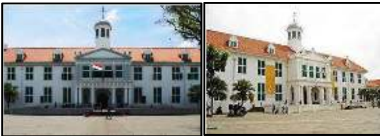
Gambar 2.45. Museum Fatahillah Museum Fatahillah merupakan bangunan bergaya Neo-Classic yang terletak di jalan Taman Fatahillah No.1, Kota Jakarta Barat
