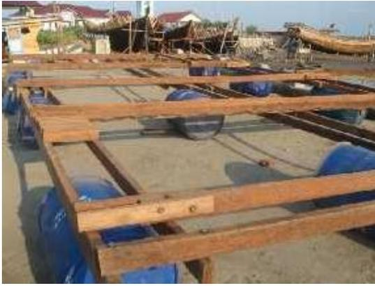
Gambar 5.7. Pemasangan drum pelampung didarat untuk diturunkan ke sungai-Laut
