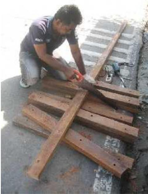
Gambar 5.5 Persiapan dan pemotongan kayu untuk kerangka keramba
