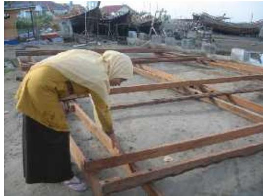
Gambar 5.6. Pemeriksaan kerangka keramba setelah perakitan
