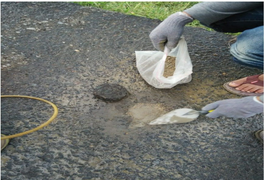
Gambar 4.17 Penutupan Perkerasan Struktur Jalan
