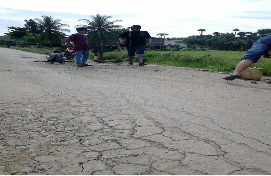
Gambar 4.4 Survei Kondisi Kerusakan Struktur Jalan
