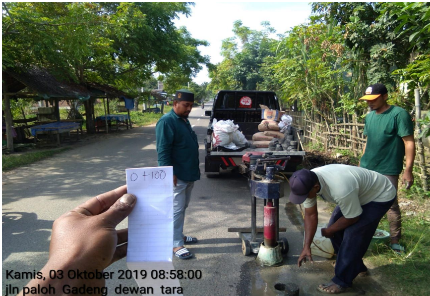
Gambar 4.19 Core Drill Sta 0+100
