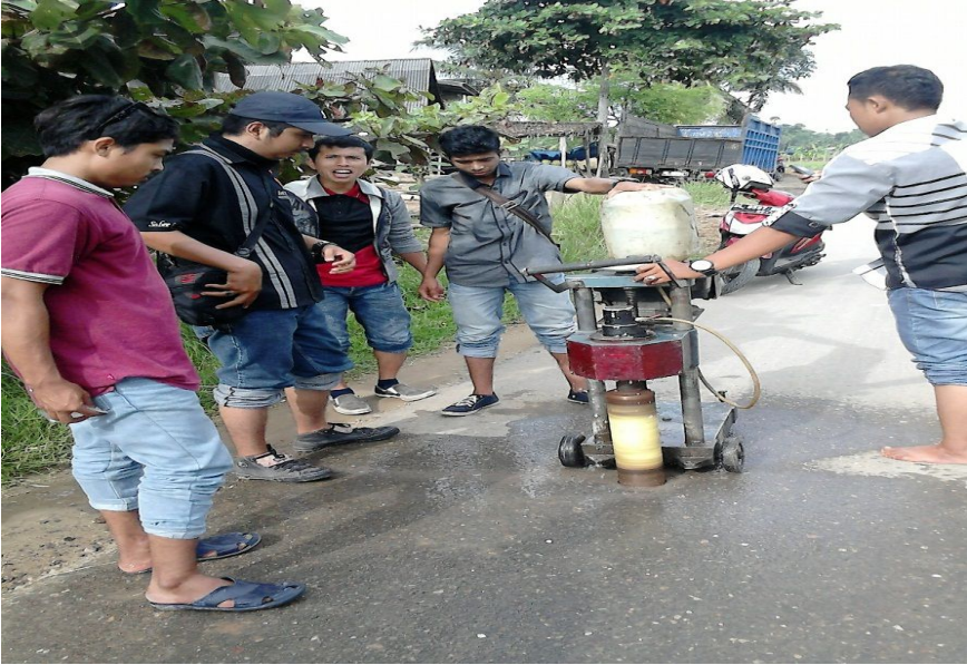
Gambar 4.6 Pelaksanaan Core Drill pada Struktur Jalan Baik
