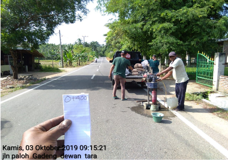
Gambar 4.22 Core Drill Sta 0+400
