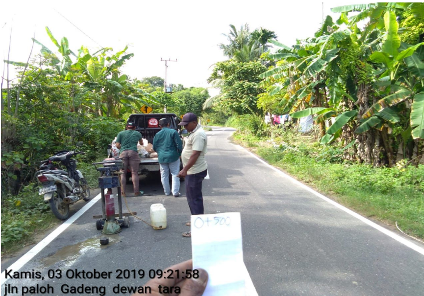
Gambar 4.23 Core Drill Sta 0+500
