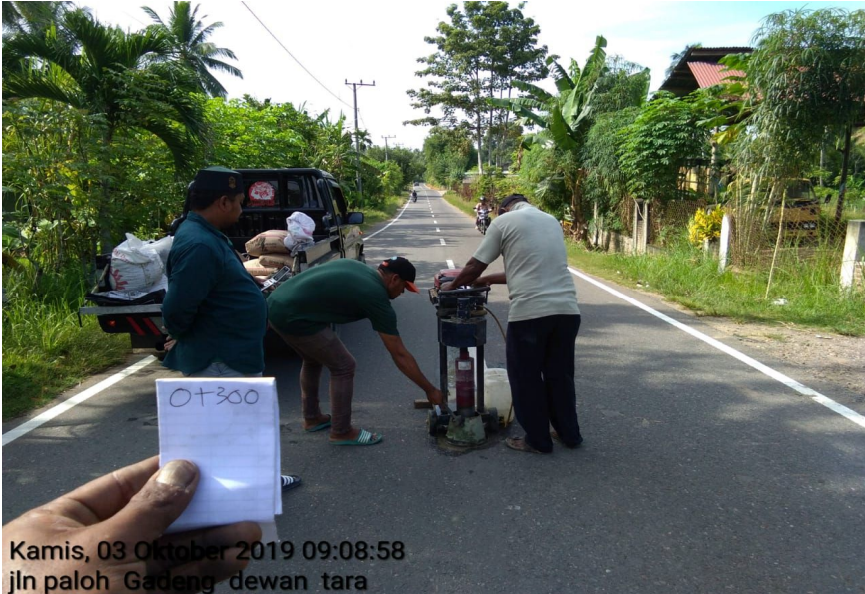
Gambar 4.21 Core Drill Sta 0+300
