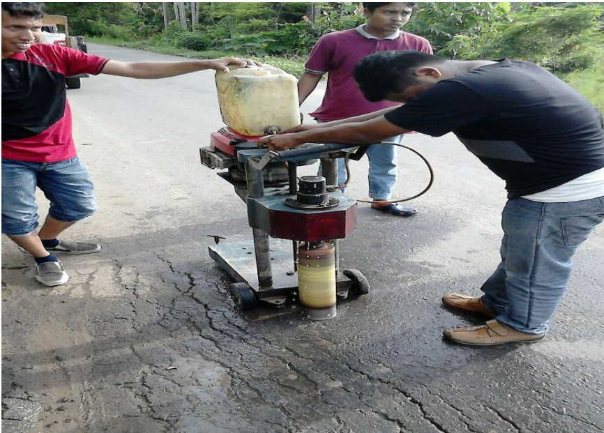
Gambar 4.5 Pelaksanaan Core Drill pada Kerusakan Struktur Jalan
