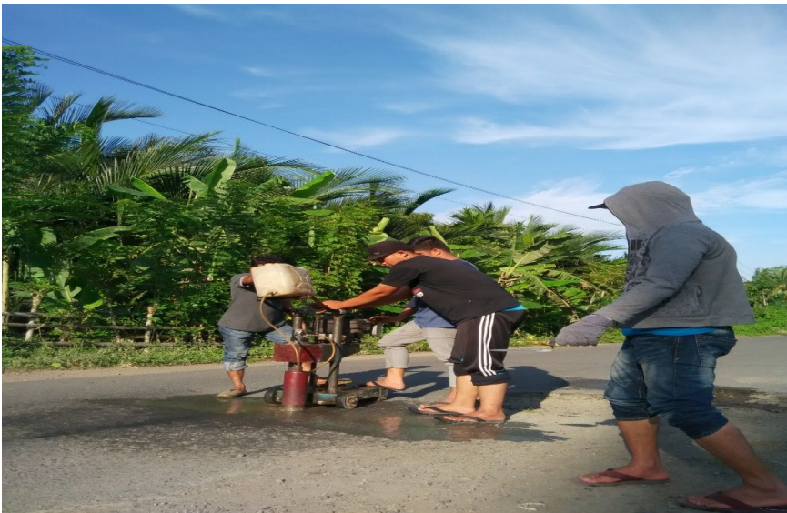
Gambar 4.11 Survei Kondisi Kerusakan Struktur Jalan
