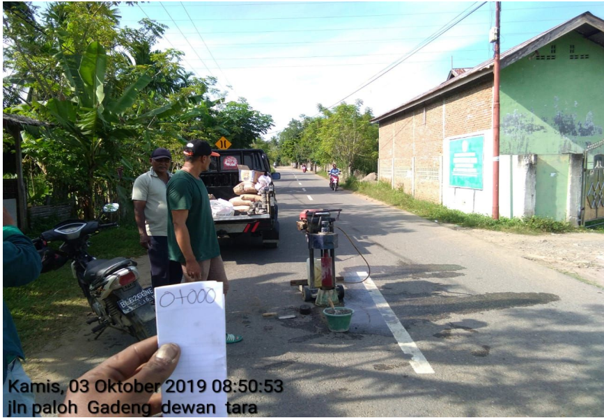
Gambar 4.18 Core Drill Sta 0+000
