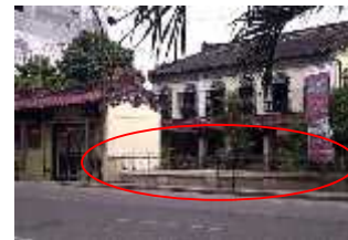
Gambar 12. Elemen Dinding Pembatas Transparan pada Rumah Tjong A Fie Sumber: Data Lapangan, 2013
