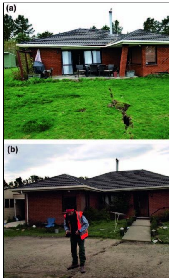
Gambar 2.4 Jalur rekahan gempa yang melewati rumah perkebunan di Canterbury, New Zealand akibat gempa Darfield yang terjadi pada tanggal 4 September 2010, lebar jalur rekahan antara 0.5 – 1 meter. a) tampak belakang rumah b) tampak depan rumah.
